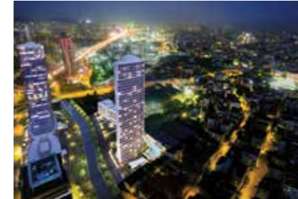
Teknik Yapı Deluxia Park Rezidans, Istanbul (9 ünite, 2,50 m/s)
